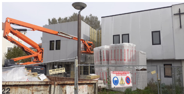
3 octobre 2023 - L'isolation et le parement extérieurs commencent.
