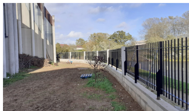
3 novembre 2023 - Installation de la clôture extérieure.
