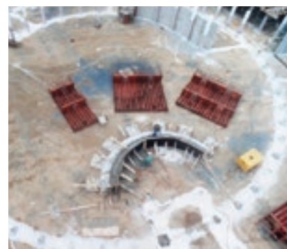
Coulage des fondations : le cercle se dessine
