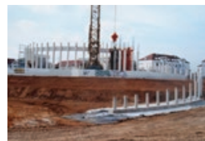
125 poteaux sortent en spirale du futur étang
