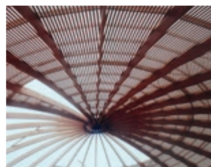
Montage de la magnifique charpente
